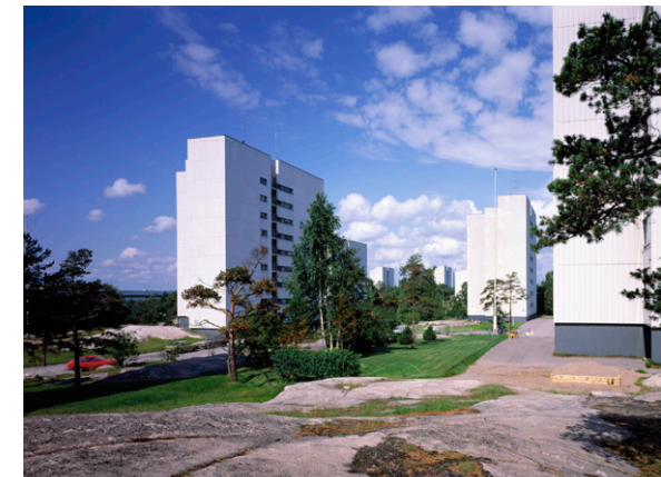
Pihlajamäen asuntoalueen lounaisosa. Kuvassa arkkitehti Lauri Silvennoisen tornitaloja. Kuva: SRM/ Simo Rista.
