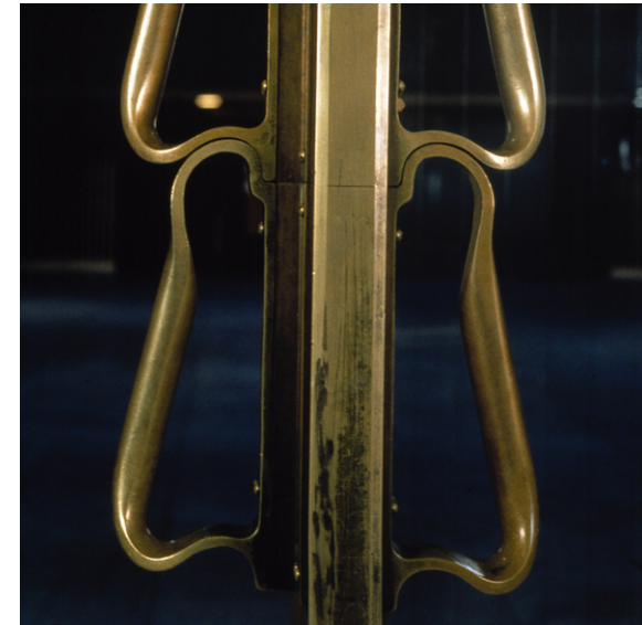
Alvar Aalto: Rautatalo, yksityiskohta. Kuva: SRM/ Jussi Tiainen.
